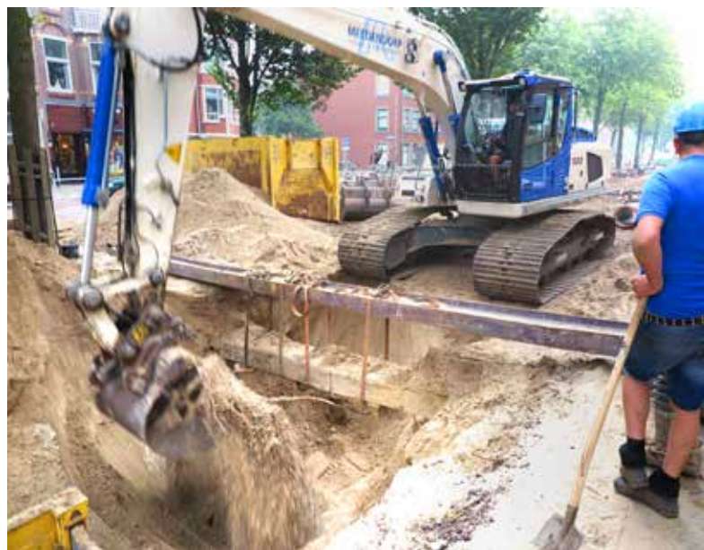
Willem de Zwijgerlaan krijgt nieuwe riolering
