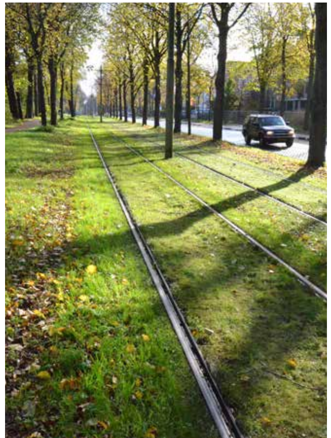
Een ogenschijnlijk kaarsrechte trambaan die toch al aan het verzakken is
