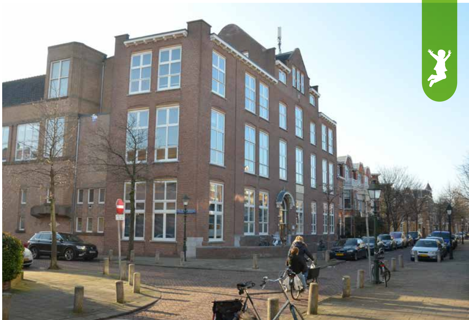
Schoolgebouw Antonie Duyckstraat
