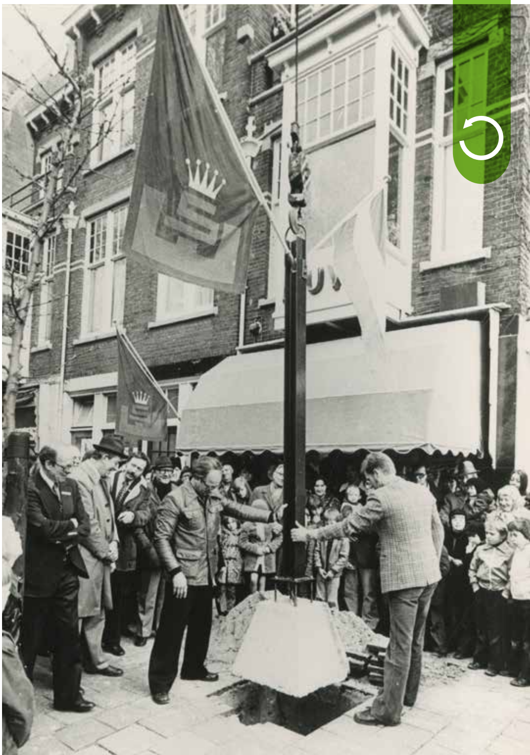
Met plaatsing van de eerste paal, of poer, voor slagerij RUVA(nu Boosty) start het project. Bron: AD
