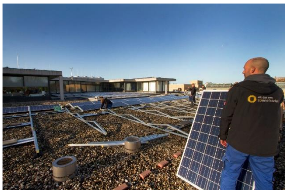
De installatie van 208 zonnepanelen op het dak van het Museon
