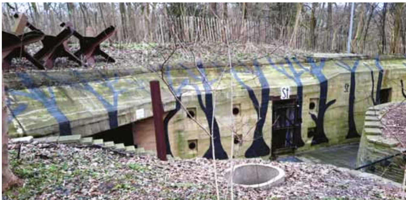
Ingang commandobunker Badhuisweg 'Stützpunktgruppe Scheveningen'
